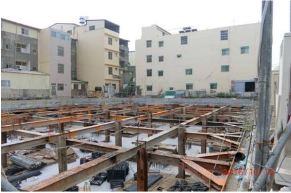
水平支撐現況照片
